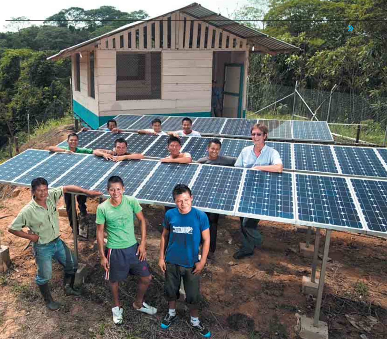
Peter May, a la derecha, con varios hombres en Curaray junto al sistema de 1,6 kilovatios que alimenta tres bombas de agua que proporcionan agua potable limpia a la aldea
