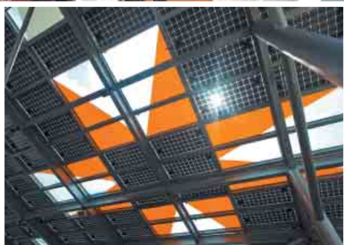
El sistema de 10 kilovatios de Isofotón en el Museo Guayasamín, el primer sistema conectado a la red eléctrica en Ecuador, tiene la forma del símbolo de ocho puntas del dios sol «Inti».
