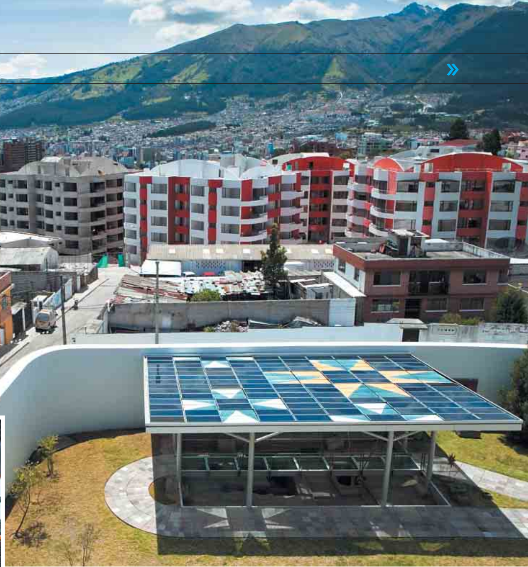
El sistema de 10 kilovatios de Isofotón en el Museo Guayasamín, el primer sistema conectado a la red eléctrica en Ecuador, tiene la forma del símbolo de ocho puntas del dios sol «Inti».
