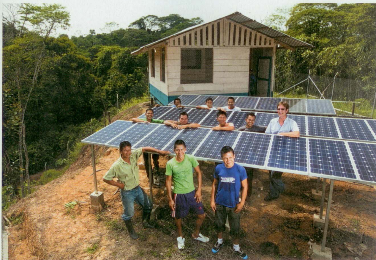
Peter May (a destra, con gli occhiali) presso il campo fotovoltaico da 1,6 chilowatt, con alcuni uomini e ragazzi di Curaray. Il generatore aziona tre pompe per l'acqua potabile per 350 abitanti.
